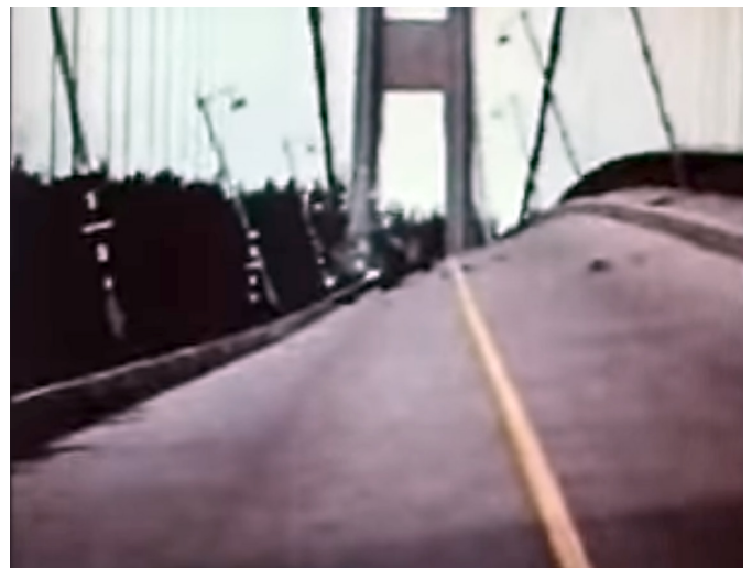
Fotografia 1. Most na w miejscowości Tacoma (USA) w stanie rezonansu
