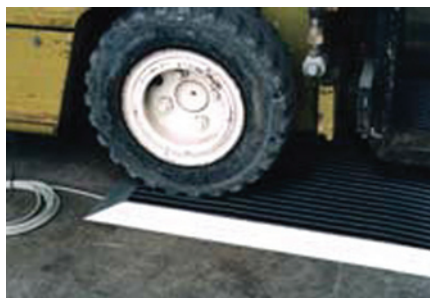
Fot. 4. Zastosowanie maty ochronnej w systemie załadunkowym
