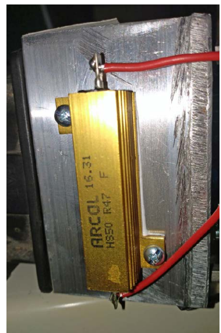
Fotografia 8. Sposób montażu rezystorów pomiarowych R13 i R14
