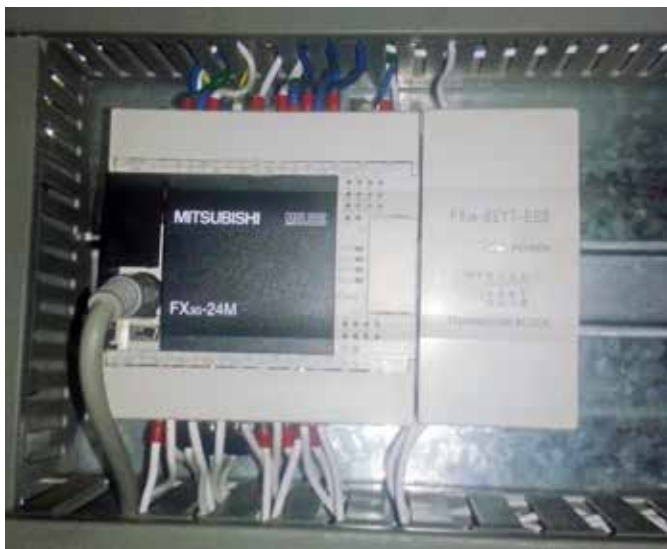
Fotografia 2. Sterownik PLC z serii FX3G zastosowany w projekcie
