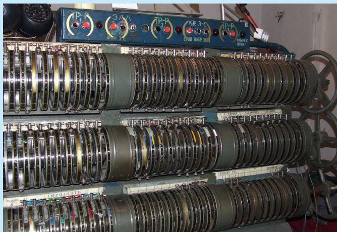
Fotografia 3. Nastawnia do sterowania oświetleniem typu Bordonii (fotografia Krzysztof Woźniak)
