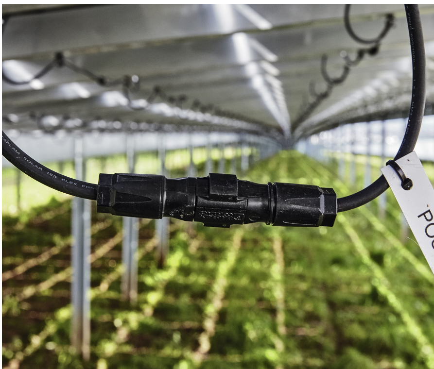
Fotografia 1. Złącza do instalacji fotowoltaicznych pracują na zewnątrz, narażone na czynniki środowiskowe. W takich aplikacjach kluczowa jest szczelność
