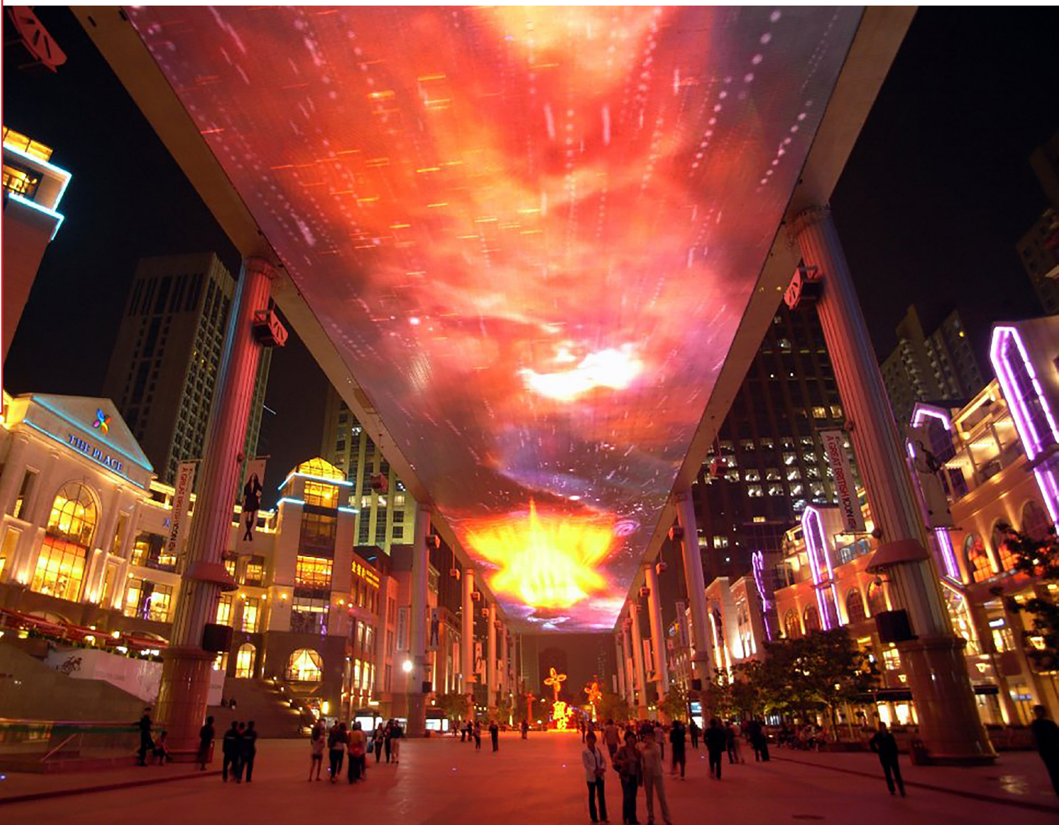
Fotografia 21. Baldachim LED o powierzchni 6000 m 2 w Pekinie
