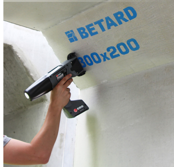
Fotografia 2. Wykonywanie nadruku na konstrukcjach betonowych o wielkich rozmiarach, np. wewnątrz skrzynekowych przepustów
