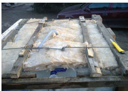
Fotografia 6. Stelaż wzmocniony linkami stalowymi
