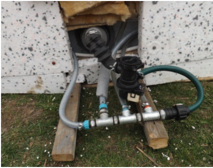
Fotografia 13. Pompka oraz czwórnik z wyprowadzeniami czterech węży
