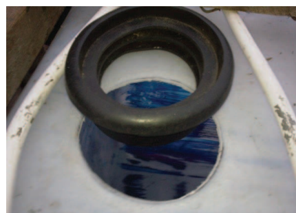
Fotografia 11. Uszczelka wyprowadzenia rury PCV na zewnątrz zbiornika
