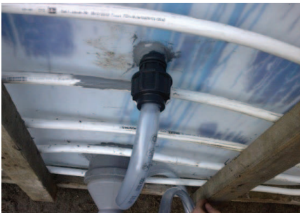
Fotografia 15. Wprowadzenie jednej z czterech dysz mieszadła do wnętrza komory
