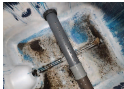
Fotografia 9. Rura z otworami umieszczona wewnątrz komory
