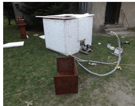
Fotografia 8. Komora fermentacyjna w trakcie prac wykończeniowych
