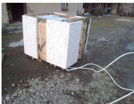
Fotografia 7. Ocieplenie komory warstwą styropianu
